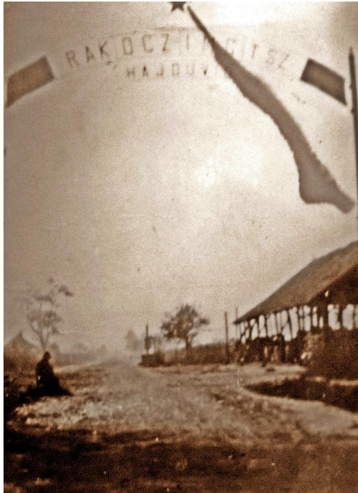
5. ábra: A Rákóczi Tsz. bejárata az 1950-es évek végén.
